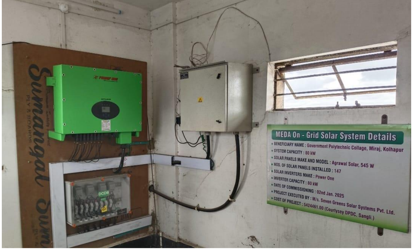
छायाचित्र क्र. २ : इन्व्हर्टर व नियंत्रण प्रणाली
